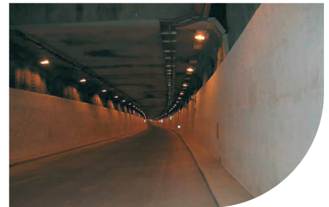
"CIRCONVALLAZIONE NORD" TUNNEL LINING - ROME - ITALY
