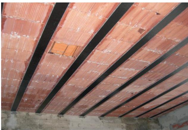
**HOHLKÖRPERDECKE AUS BETON UND ZIEGEL
